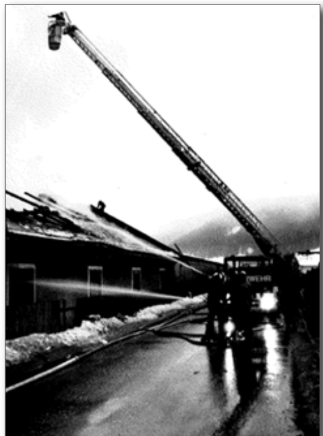
Brand Zuegg (Papierfabrik), Möderbrugg – ausgelöst durch Schweißarbeiten
