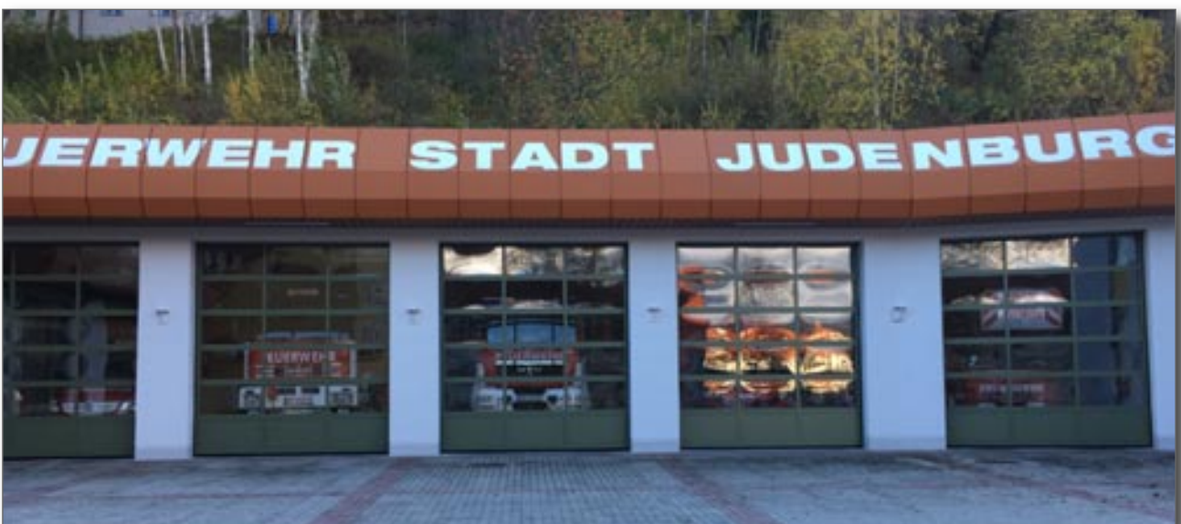
Sanierung Rüsthaus – Austausch der Tore und Sanierung der Fahrzeughalle
